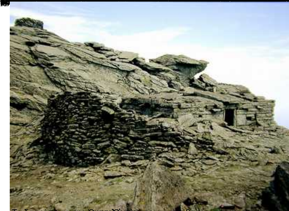
Το δρακόσπιτο της Οχιάς, τα αντίβαρα και οι περισσότεροι σγκόλιθοι της κατασκευής
